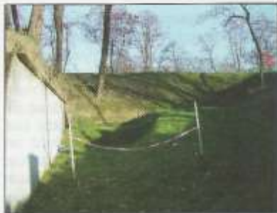
Stanowisko prawe po
